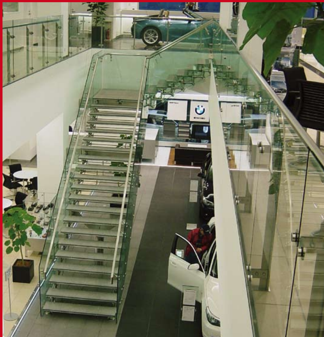
BMW - TOKIO - Mod. REGALE Struttura. in acciaio inox. Gradini. in ceramica Ringhiera. in vetro 10+10+1,52 PVB
